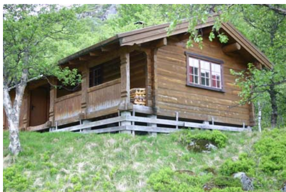
Bru over Byrteåa i Nedre Byrtedalen, og hytte bygd i Ormekvålen
