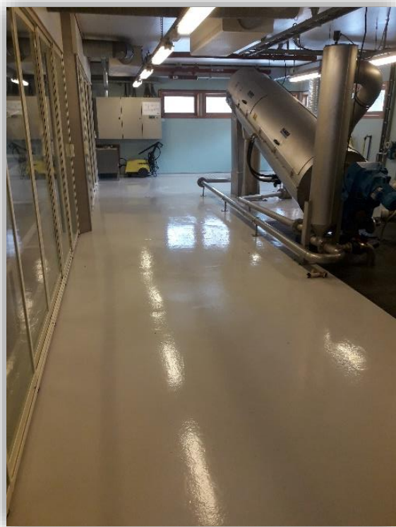
Figur 2 Golvet på Dalen RA - Ny epoxy
