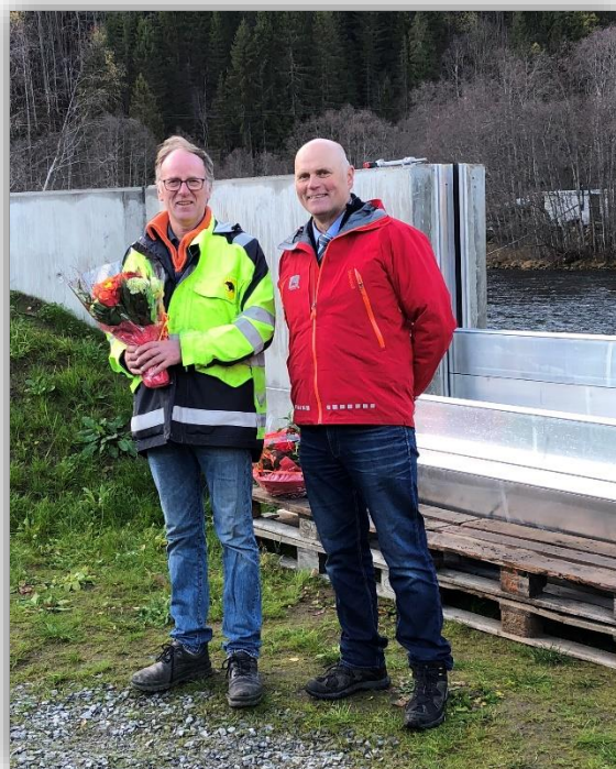
Sven Arne Gjerstad, NVE og arbeidsformann Torgeir Midjås var sentrale i gjennomføringa av flaumsikringsarbeidet - Tokkeåi
