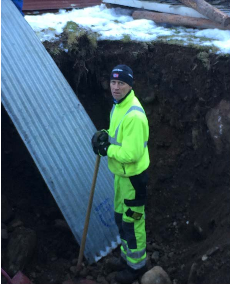
Arbeid med VA-nett i egen regi. Bilete frå omlegging av kloakk.
