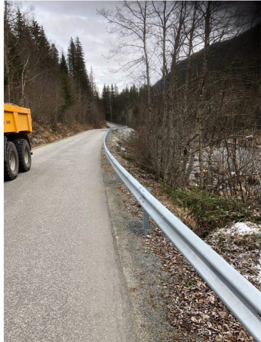
Trafikksikring i Modalen
