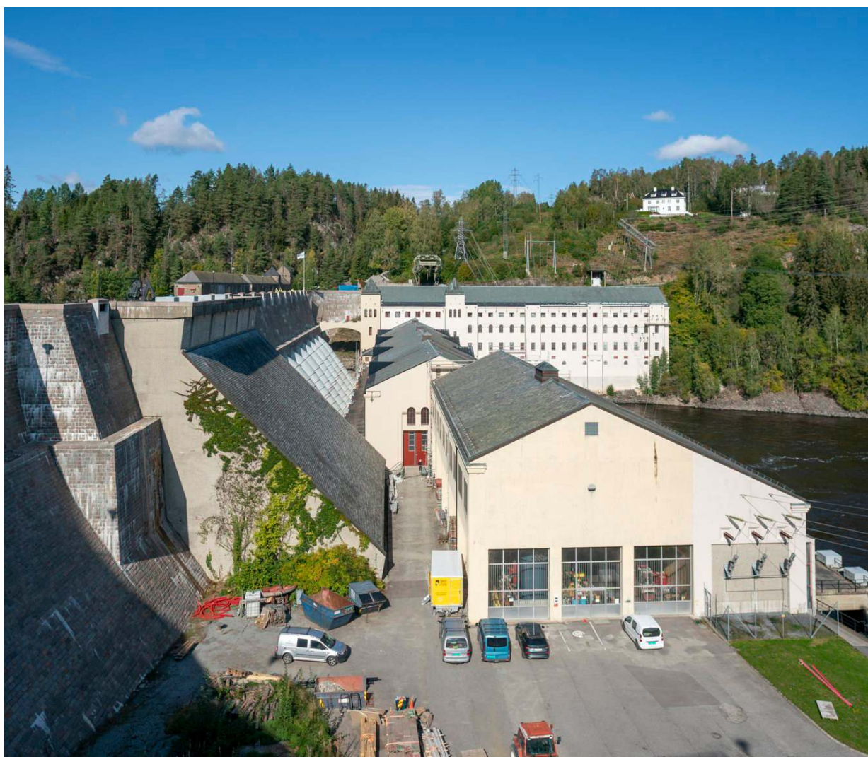
Nettverk for kommunale vannkrafteiere vil ha endringer i innretningen av grunnrenteskatten, slik at en større del av verdiskapingen blir igjen hos eier- og vertskommuner. Bildet viser Vamma kraftverk og Vamma 12 i Skiptvedt.
