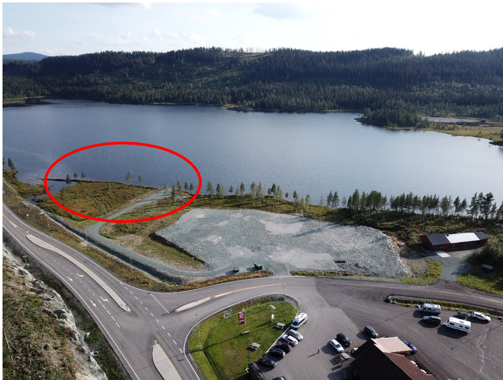
Aktuelt område for etablering av rasteplass ved Oftevatn
