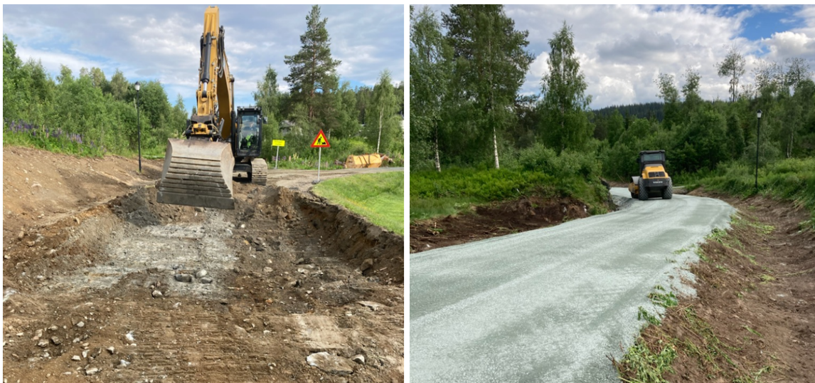
Masseutskiftning, Bakkenfeltet i Høydalsmo.
