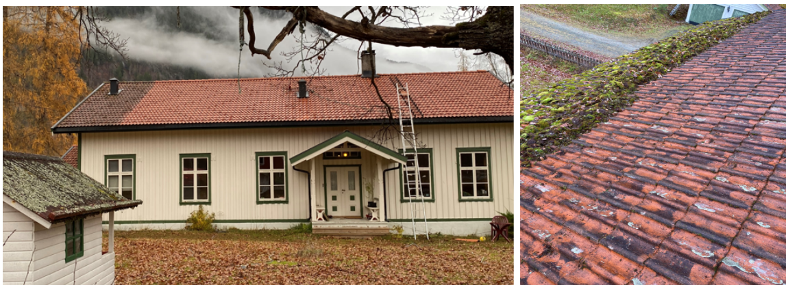
Fjerning av møsi på tak, prestegaden i Lårdal.
