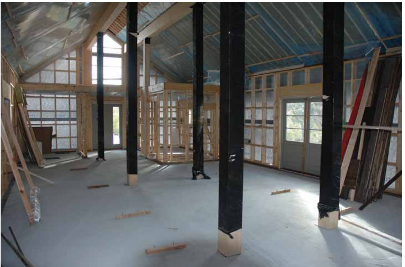
Fjellkyrkja 18.september 2008. Vi ser at taket har kome på, det står att å kle utvendig, og isolere og kle innvendig.
