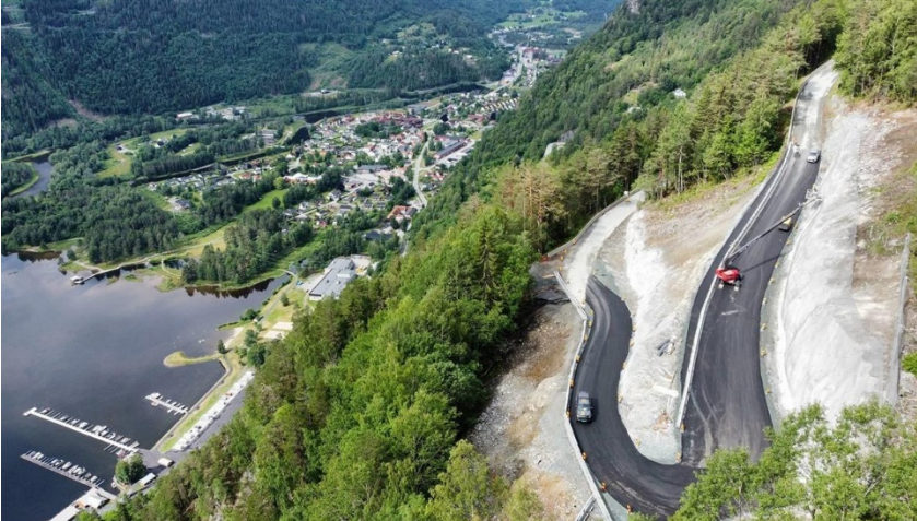
Utskliding i grunn som gjorde det naudsynt med utbetring.
